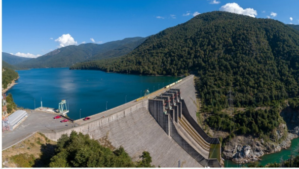
Central Hidroeléctrica Pangué, Región del Biobío.
