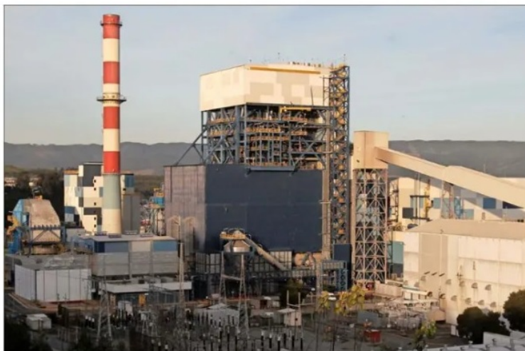
El plan de Enel Chile era sacar de funcionamiento la unidad Bocamina II en mayo de 2022, y así poder convertirse en una empresa libre de carbón, estrategia que tendrá que postergarse.
